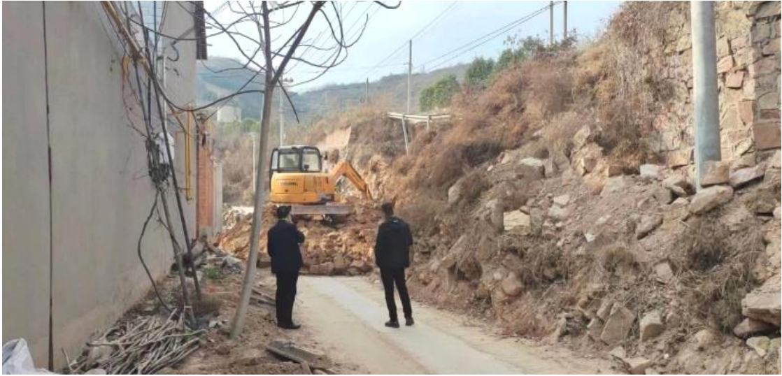
图 1 项目开工第一天的施工照片
